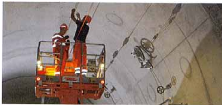
16 Versuche zur Montage der Fahrleitung
