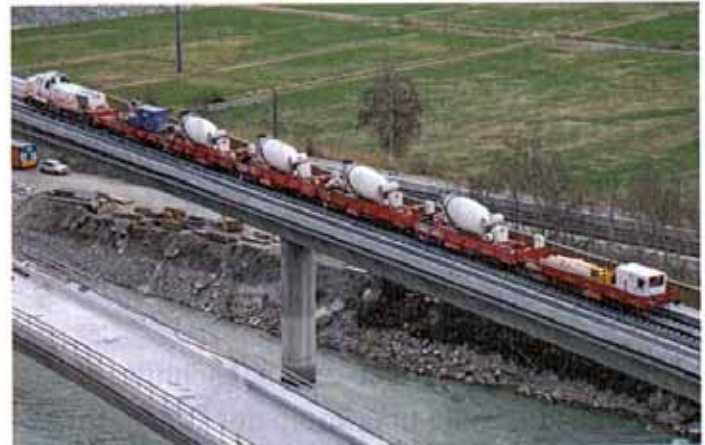
19 Einfahrt eines Betonzuges in den Basistunnel in Raron
