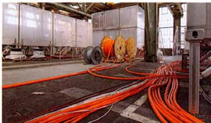
15 Testphase in der Containerhalle
