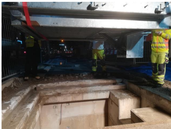
Schachtabdeckungsklappe bereit für den Einbau in die Aussparung der Haltestellendecke
