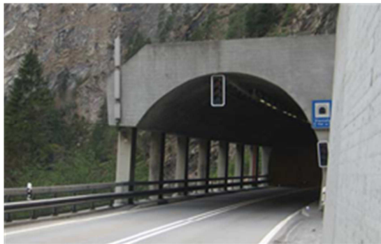
Nordportal Viamala mit Galerie
