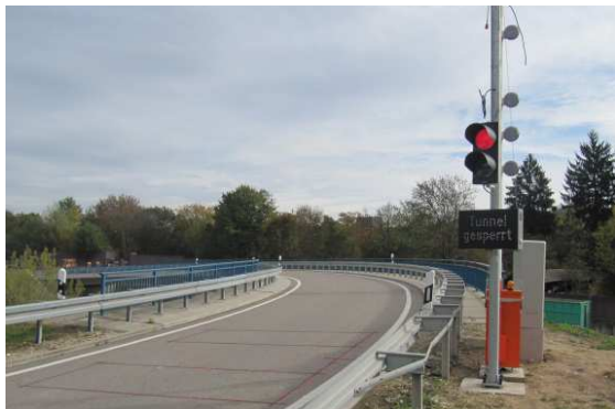
Schrankenanlage im westlichen Vorfeld
