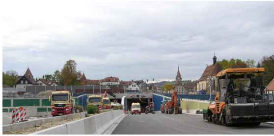
Ostportal Gmünder Einhorn-Tunnel
