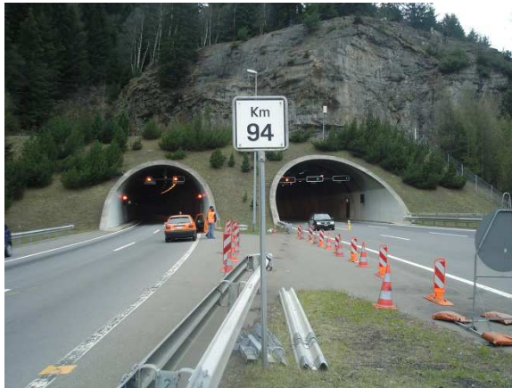
Südportal des Tunnels Pardorea
