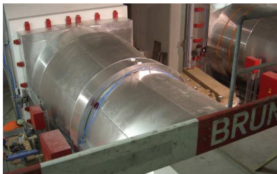
Montage der neuen Abluftventilatoren
