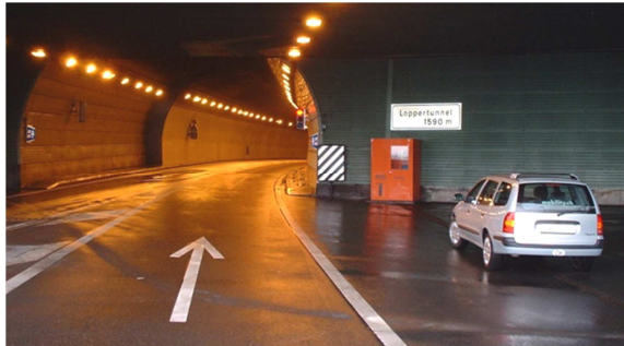
Nordportal des Loppertunnels
