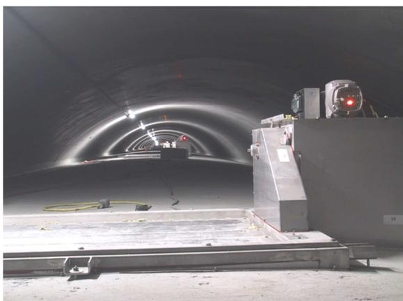
Abluftkanal mit Abluftklappen und Klappenantrieb
