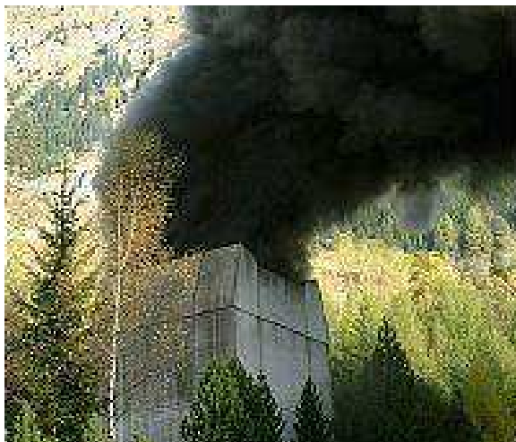
Entrauchungsschacht im Brandfall
