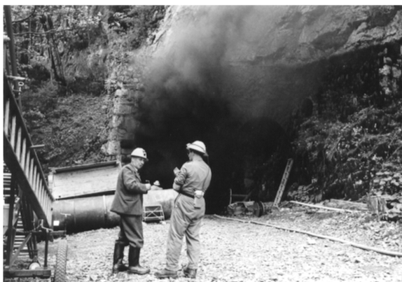
Erste Brandversuche der HBI 1965 im Ofenegg Tunnel
