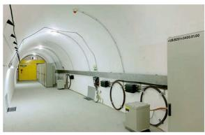
Schaltschränke in einem Querschlag zur Unterbringung der Bahntechnik
