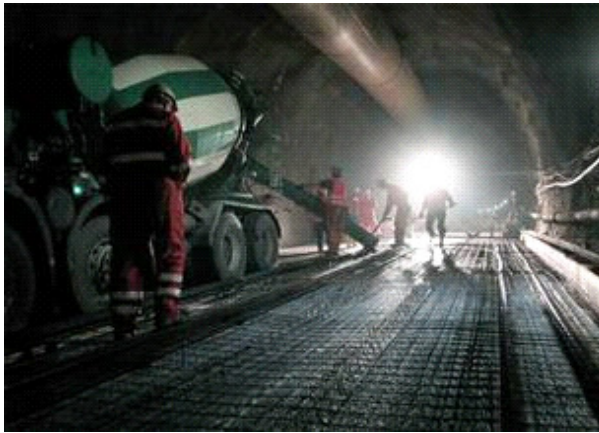
Betonierung der Tunnelsohle unter Einsatz der Baulüftung
